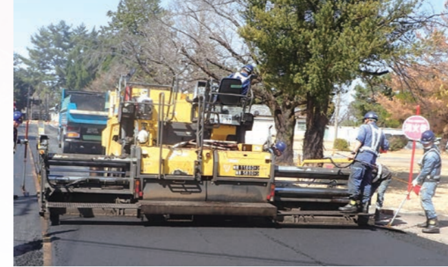
アスファルト舗装施工の様子。老朽化したアスファルトは100%リサイクルを達成
