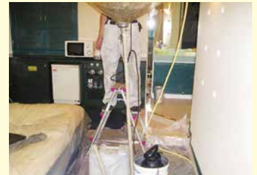
▲エアコン洗淨 作業準備
