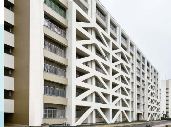
▲「ビタコラム工法」(左)と「ウッドビタ工法」(右)施工例
